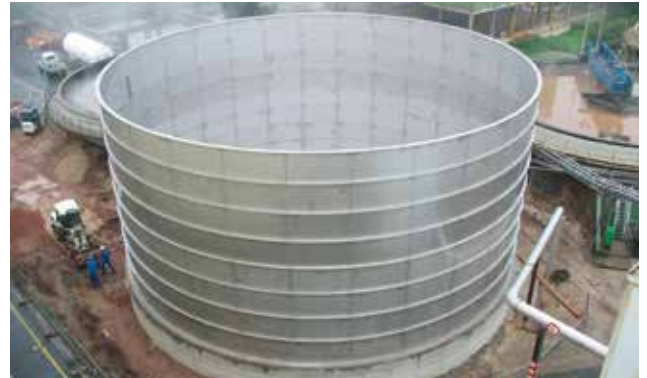
1.661 m 3 Abwasserbehälter für die Papierindustrie 1,661 m 3 Waste water tank for the paper industry
