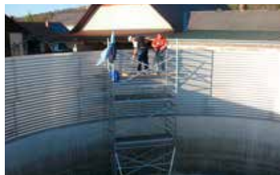
2. Ring auf Betonbehälter 2. Ring on concrete tank
