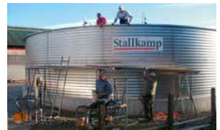
Aufgestockter Betonbehälter Heightened concrete tanks
