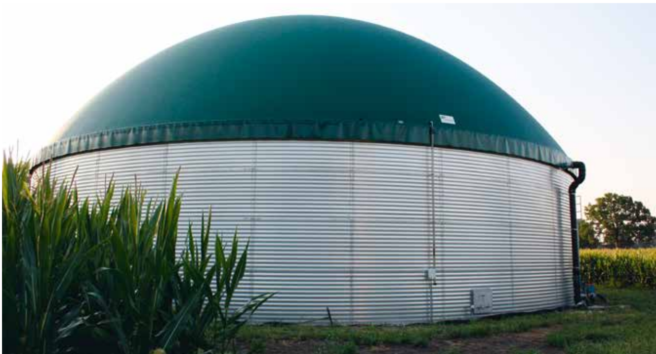
V4A Biogasbehälter mit gasdichtem Doppelmembrandach | V4A biogas tanks with gas-tight double membrane roof
