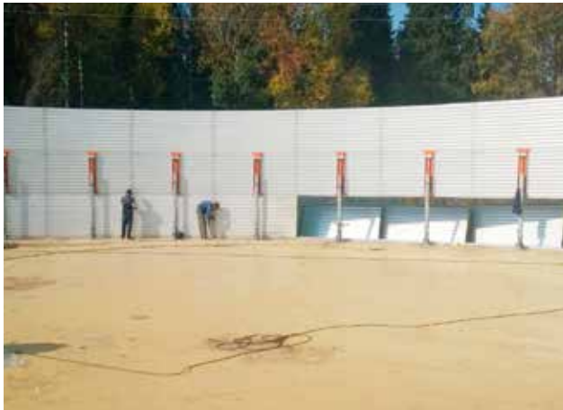
Montage mit Hebevorrichtung Assembly with lifting gear
