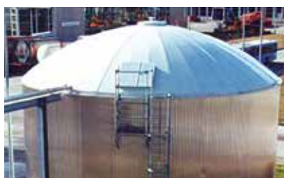
Ausführung Glattkuppeldach Smooth dome roof design
