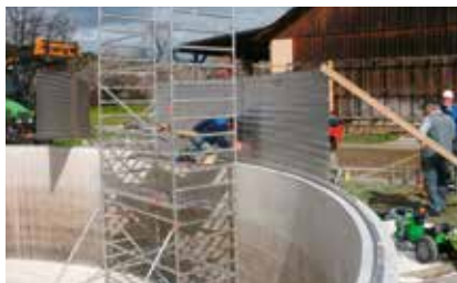
Aufstockung eines Behälters Adding height to a tank
