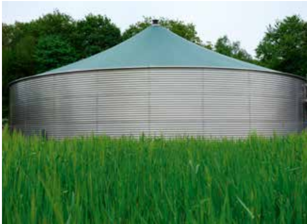
Wellstahlbehälter mit Membrandach Corrugated steel tanks with a membrane roof
