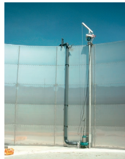
Saug- und Befüllstutzen mit Absperrschieber über die Behälterwand mit TMP | Suction and filling nozzle with shut-off valve over tank wall with TMP
