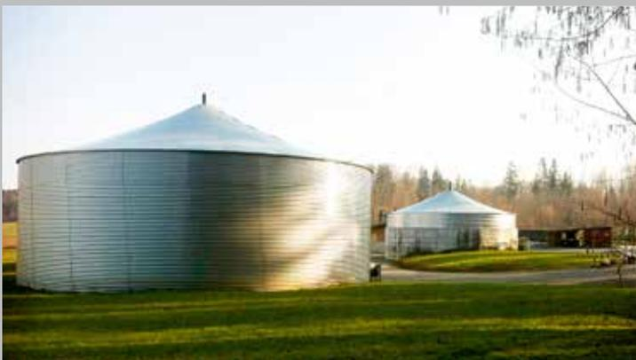
▶ Wellstahlbehälter + aufgestockter Betonbehälter
