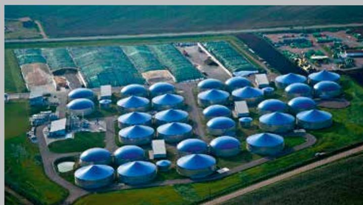
▶ Fermenter, Nachgärer und Endlager einer Biogasanlage
