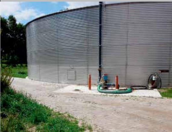
▶ Wellstahlbehälter mit Saugstation
