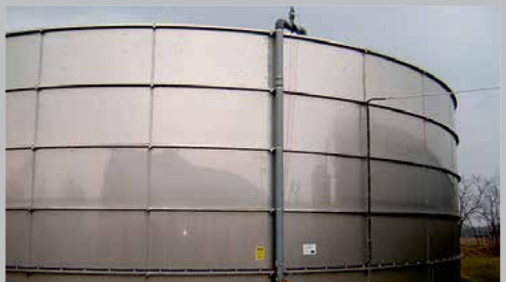
▶ Saug- & Befüllstation über dem Behälterrand ▶ Suction & filling station over the tank edge
