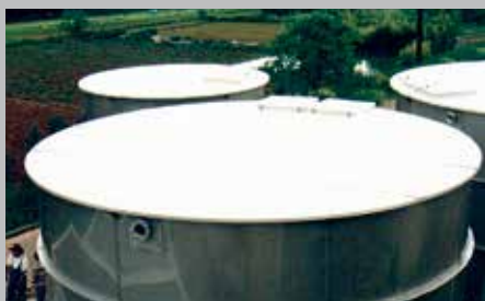
► Ausführung Flachdach ► Achievement flat roof
