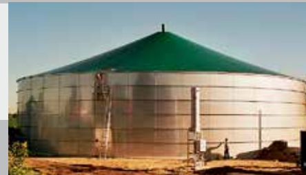
► Behälteransicht außen mit Membrandach ► Tank outside with membrane roof
