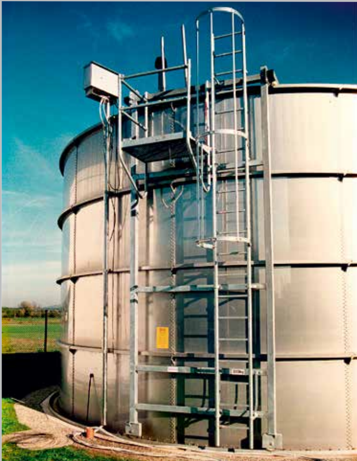
▶ Behälter mit Arbeitsbühne und fahrbarer Leiter ▶ Tank with working platform and a movable ladder
